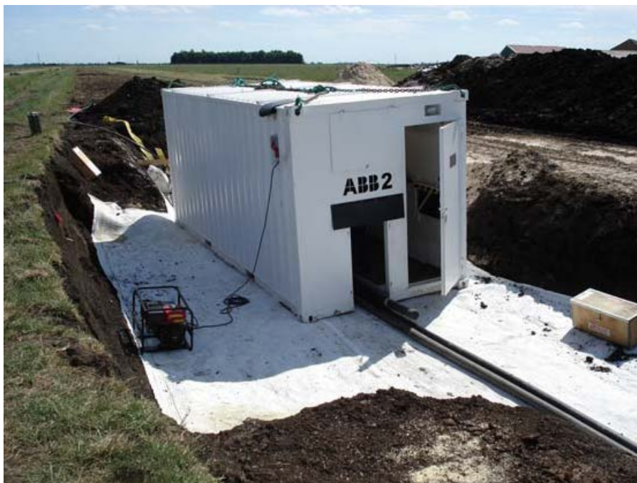
Abbildung 12: Muffengrube mit Arbeitscontainer (Quelle: ABB)
