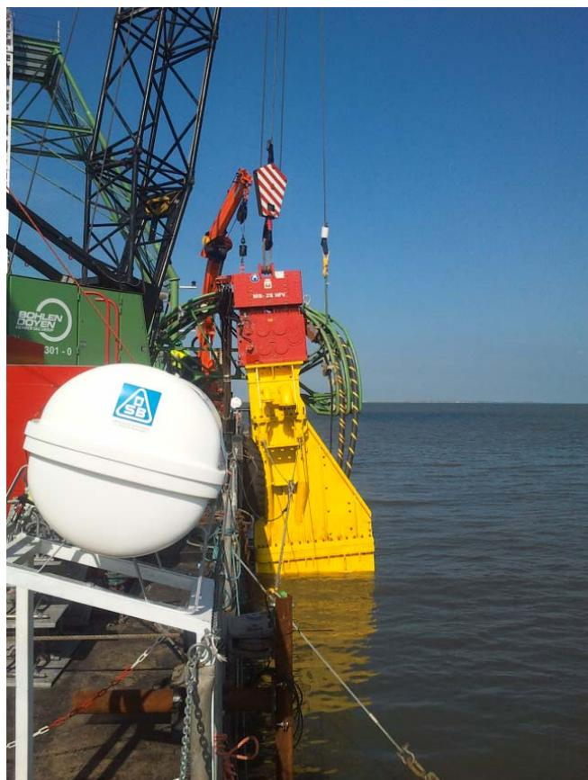
**Abbildung 19: Vibroschwert bei der Wattkabelverlegung für BorWin2 (Quelle: TenneT)**
