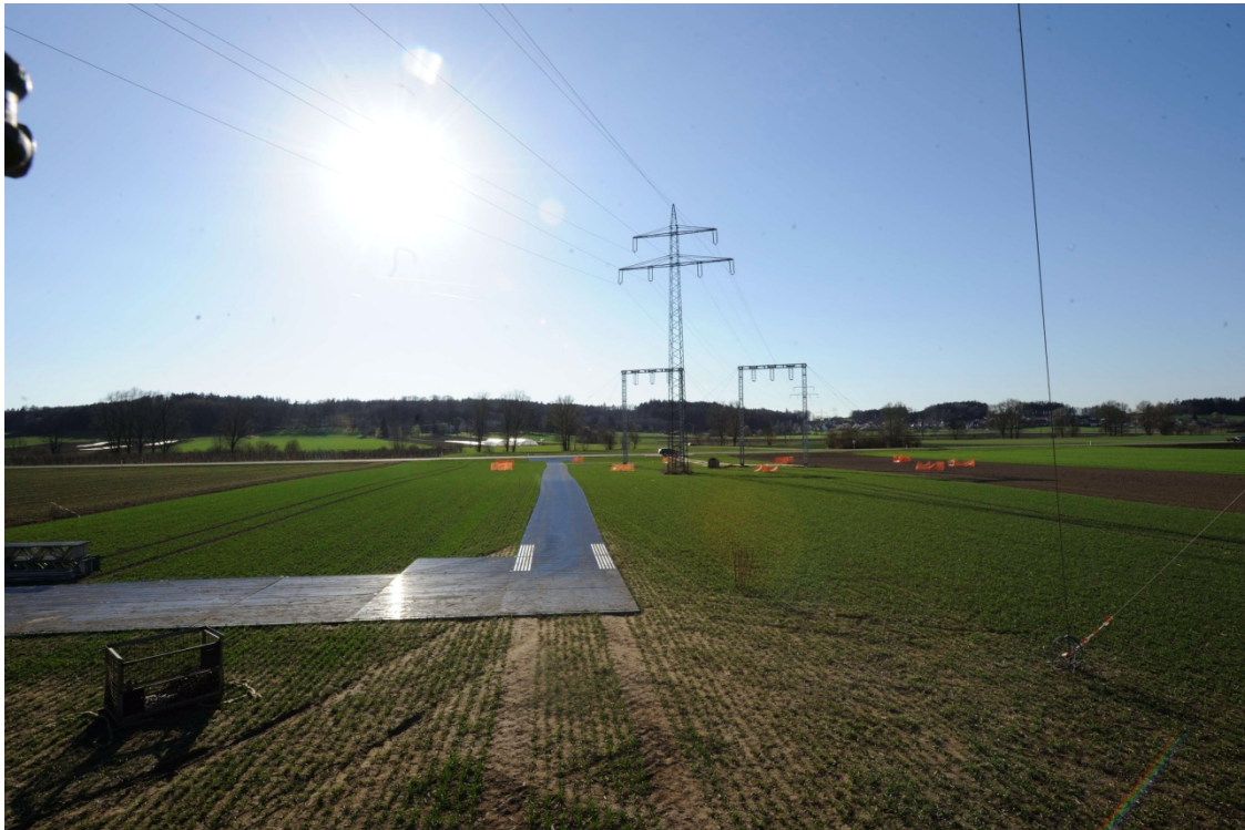
Abbildung 12: Provisorische Zuwegung als Plattenzufahrt bei einer Freileitungsbaustelle
