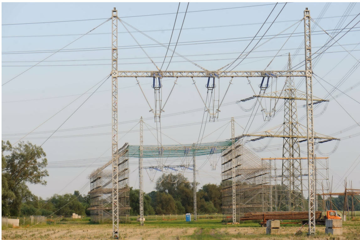
Abbildung 14: 380-kV-Freileitungsprovisorium für ein System, mit errichtetem Schutzgerüst
