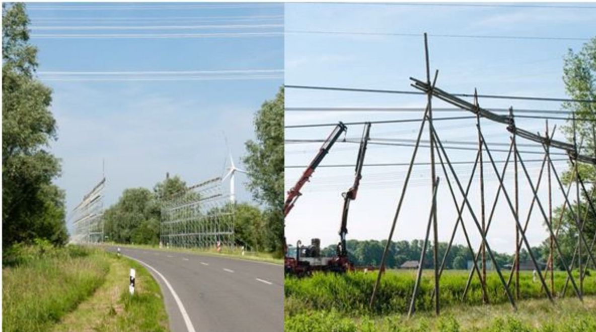
Abbildung 15: Beispiele für Schutzgerüste aus Stahl bzw. Holz
