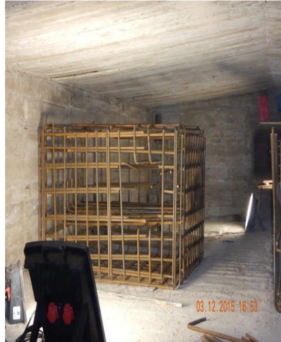
Abb. 3: Herstellung einer außenliegenden (links) und einer innenliegenden (rechts) Konsole (Bewehrungskorb) (Quelle: Eurovia Beton GmbH)
