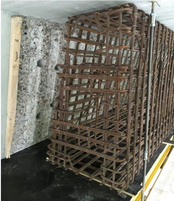
Abb. 3: Herstellung einer außenliegenden (links) und einer innenliegenden (rechts) Konsole (Bewehrungskorb) (Quelle: Eurovia Beton GmbH)
