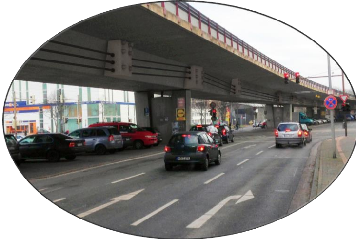
Abb. 6: Fotomontage der künftigen externen Vorspannung (Quelle: NLStBV)
