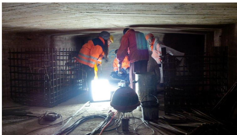
Abb. 5: Herstellung der innenliegenden Konsolen unter erschwerten Bedingungen (Quelle: Eurovia Beton GmbH)
