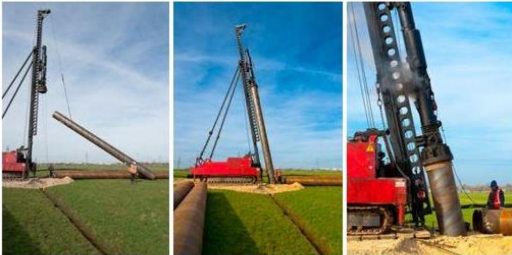
Abbildung 11: Pfahlgründung (Quelle: TenneT TSO GmbH)
