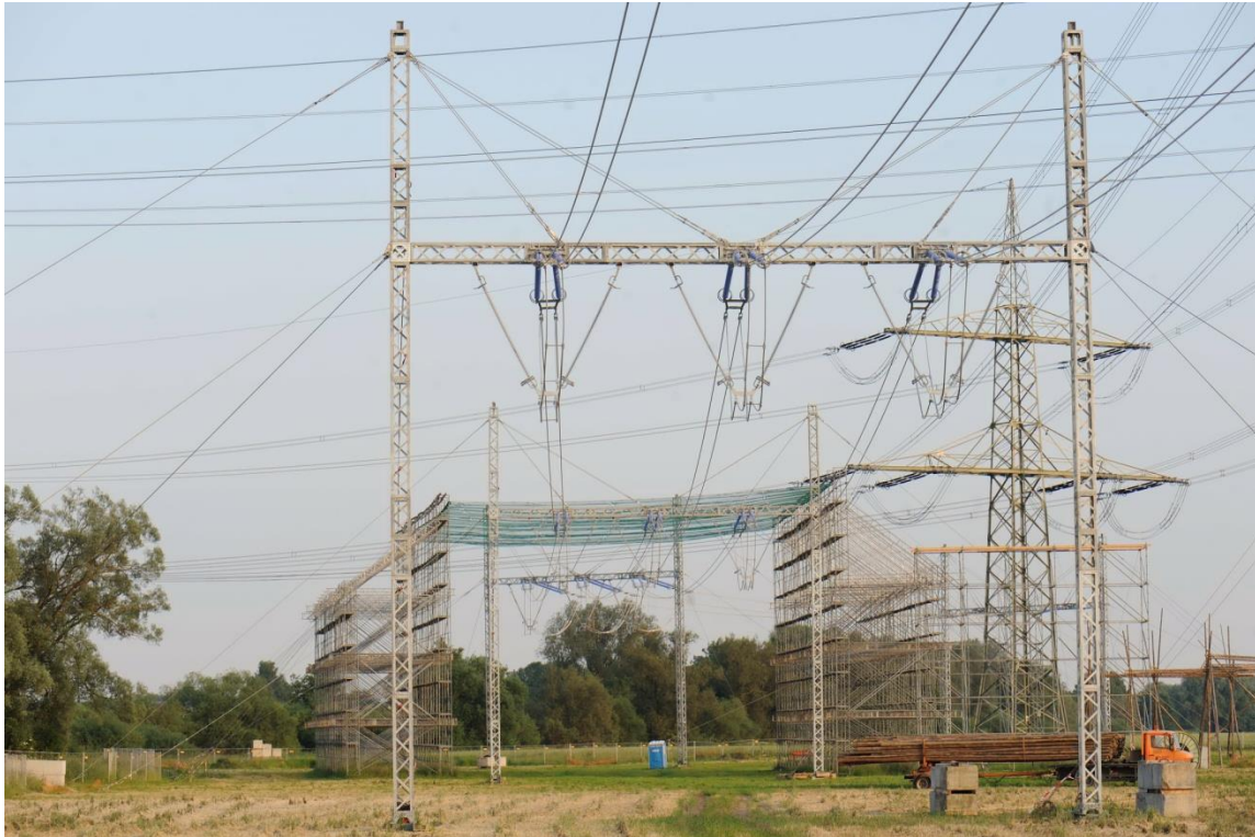
Abbildung 14: 380-kV-Freileitungsprovisorium für ein System, mit errichtetem Schutzgerüst
