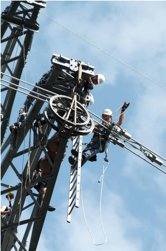
Abbildung 13: Seilzug (Quelle: TenneT TSO GmbH)
