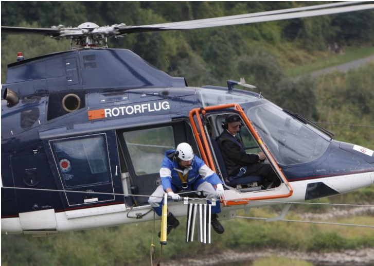
Abbildung 7: Exemplarische Darstellung der Erdseilmarkierung (Quelle: TenneT TSO GmbH)
