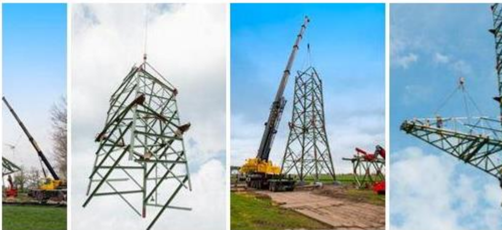
Abbildung 12: Stocken eines Freileitungsmastes (Quelle: TenneT TSO GmbH)
