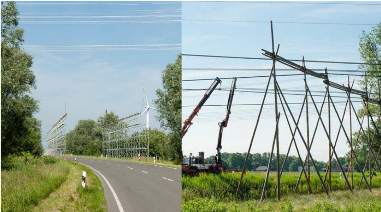
Abbildung 15: Beispiele für Schutzgerüste aus Stahl bzw. Holz
