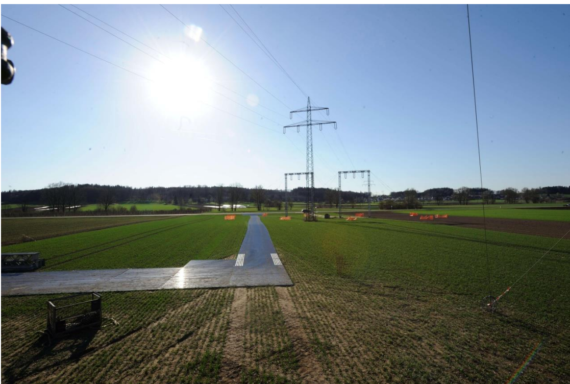
Abbildung 10: Provisorische Zuwegung als Plattenzufahrt bei einer Freileitungsbaustelle
